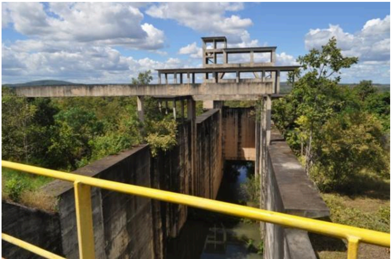
Imagem da eclusa de montante do Rio Parnaíba na Usina Boa Esperança no Piauí
