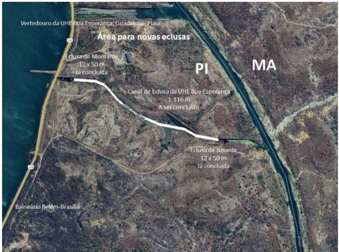
Trecho de 1.116 m de canal existente a ser concluído entre as eclusas de 12 metros de largura na UHE Boa Esperança
