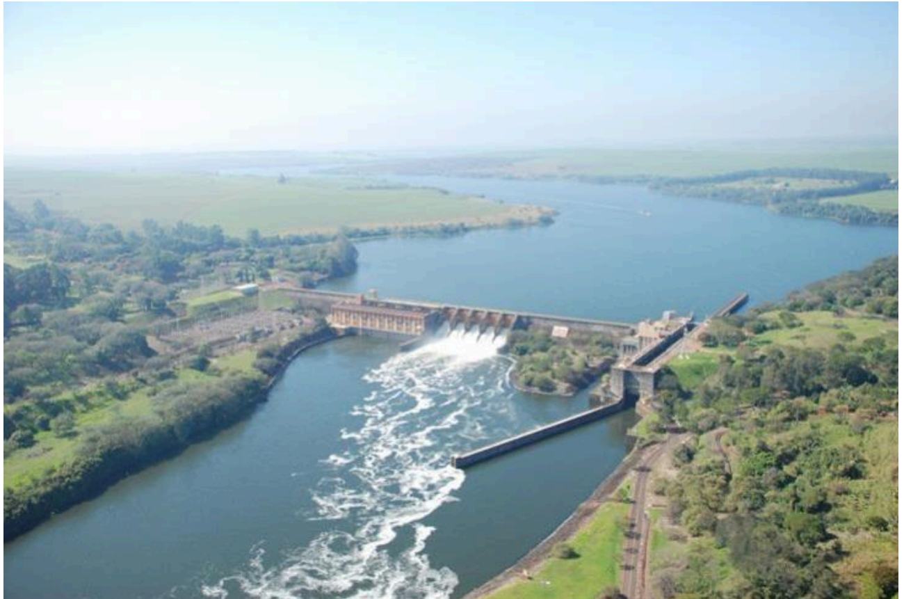
UHE Barra Bonita com 140 MW, hidrovia do Tietê, com eclusa de 12 metros largura igual à da UHE Boa Esperança
