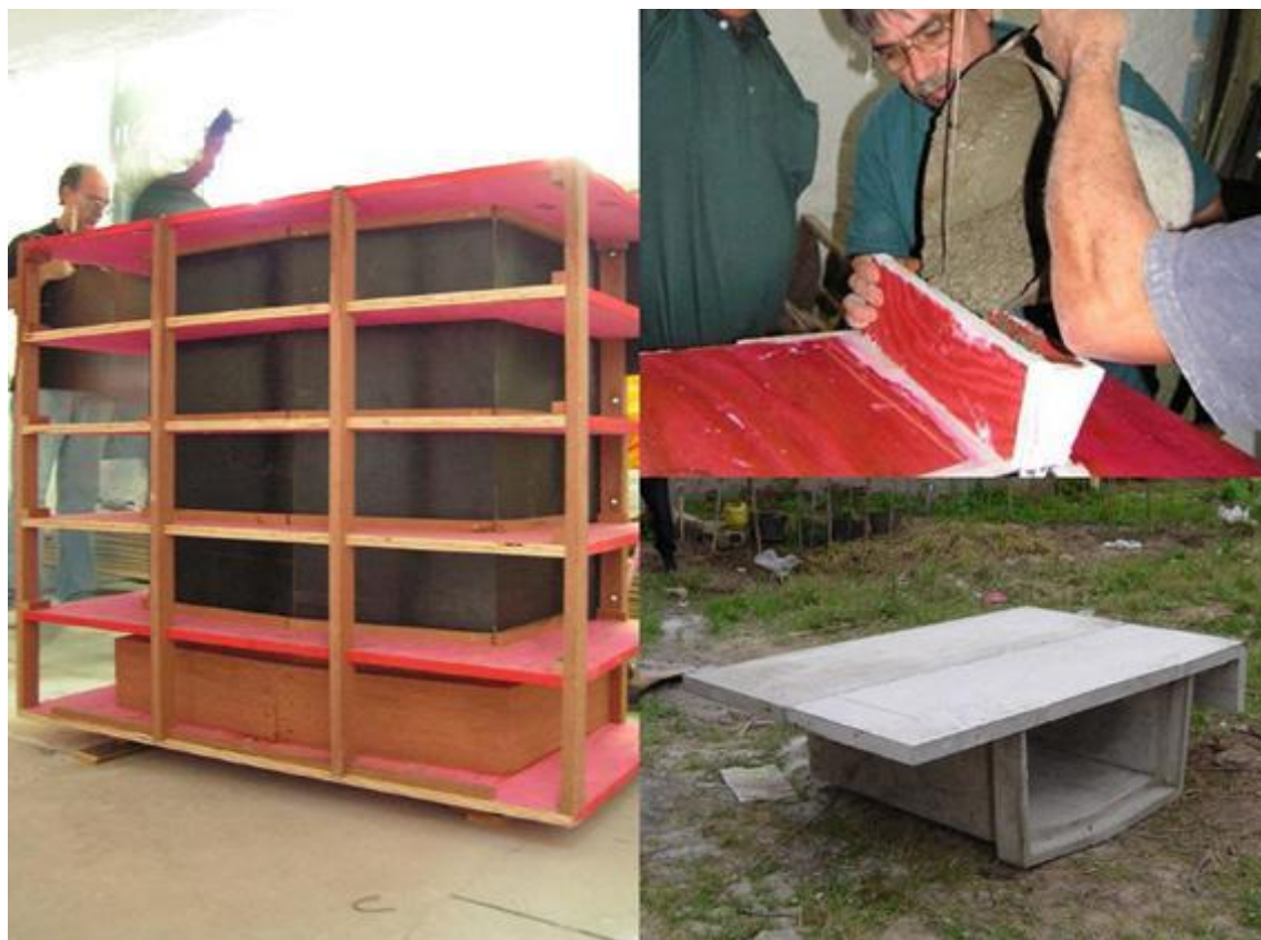
Figura 5: Execução do protótipo da calçada drenante em um centro comunitário na periferia de Montevidéu, Uruguai, em 2006.
