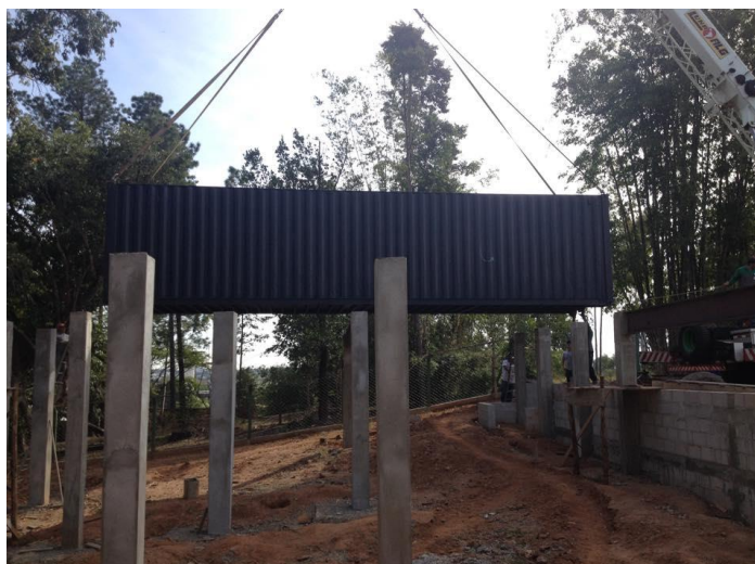
Figura 11 Pilares concretados
