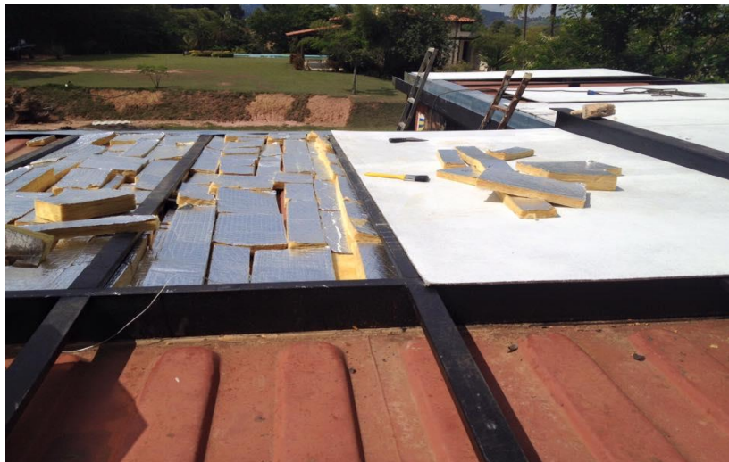
Figura 16 Aplicação do isolamento térmico e acústico em lã de rocha e lã de vidro
