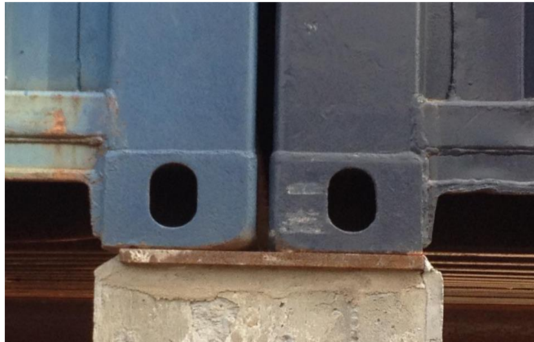
Figura 12 Compensado naval e encontro dos contêineres
