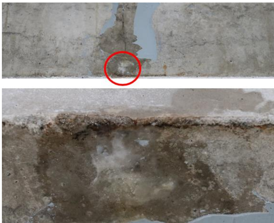
FIGURA 26 — EVIDÊNCIA DO SELAMENTO DE FISSURAS
