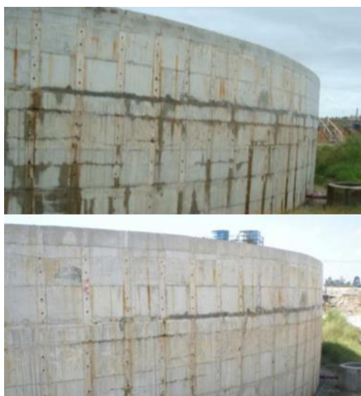
FIGURA 15 — RESERVATÓRIO CONSTRUÍDO COM CONCRETO AUTOCICATRIZANTE
