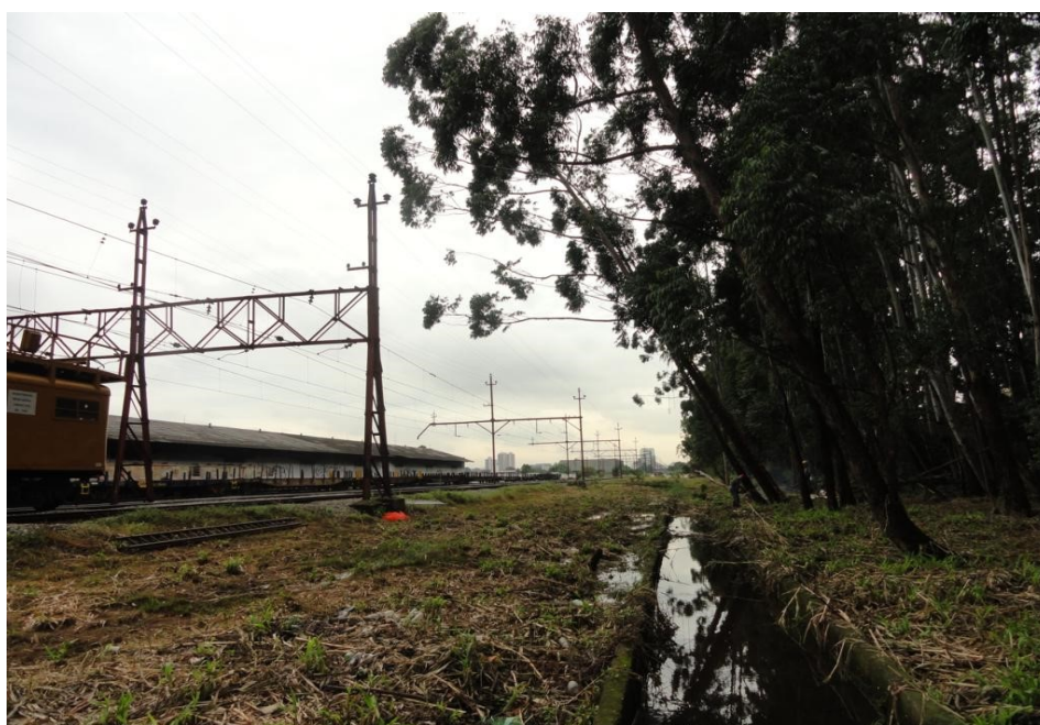
Figura 10. Foto de árvore inclinada em direção à via e Rede Aérea. Fonte: Banco de dados CPTM
