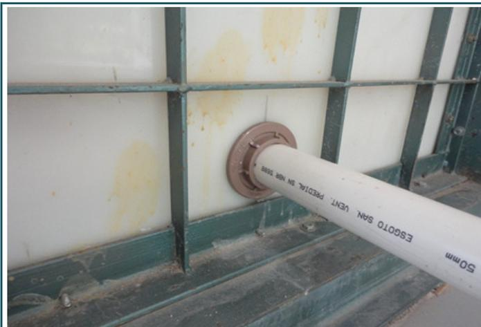
Foto B3: Detalhe da saída do tanque
