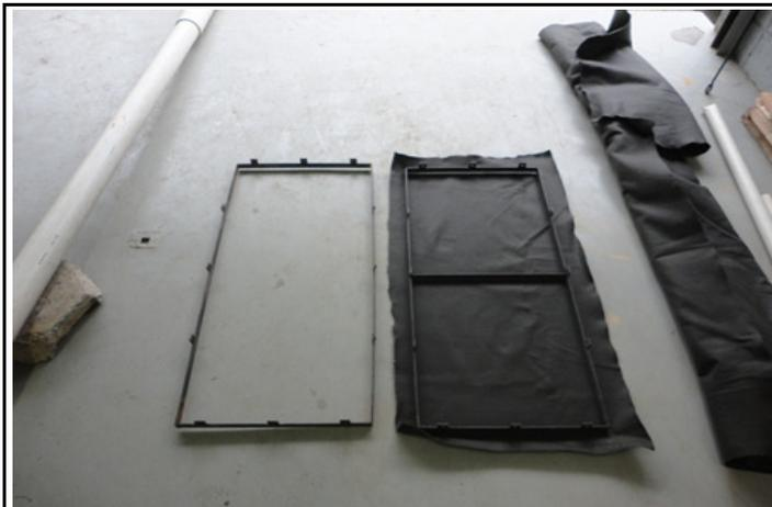
Foto B45: Montagem de cerca filtrante na armação metálica.
