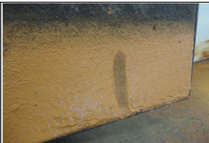
Foto B32: Sedimentos retidos na cerca, colmatando a membrana filtrante.
