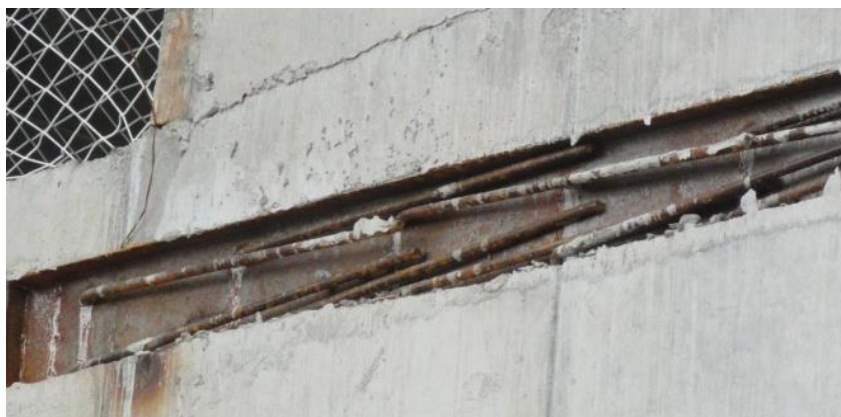
Figura 50 – Armadura de espera para ligação da laje com o núcleo
