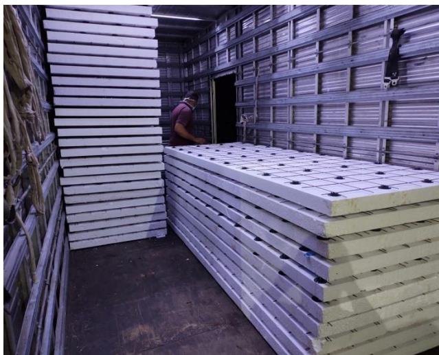
Figura 129 – Transporte de painéis de EPS
