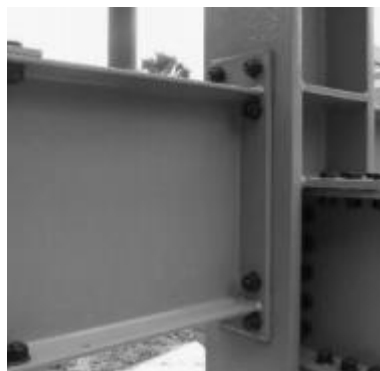
Figura 49 – Ligação rotulada de vigas com pilares H
