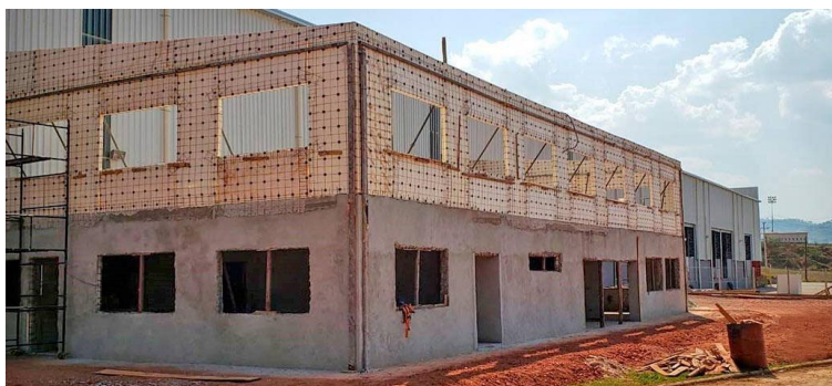
Figura 32 – Painéis estruturais de EPS em substituição a pilares e vigas em edificação
